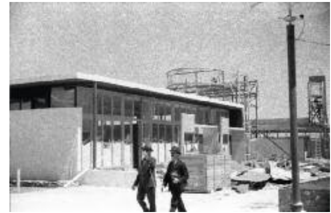
Baustelle auf dem Gelände der Orient-Messe von 1934, Tel Aviv, vor April 1934 Construction site at the 1934 Levant Fair grounds, Tel Aviv, before April 1934
