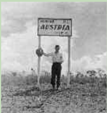
Kurt Klagsbrunn vor dem Schild der mit der Errichtung von Brasilia beauftragten staatlichen Firma Novacap, das den Bauplatz der österreichischen Botschaft markiert / Kurt Klagsbrunn in front of sign marking the site of the Austrian Embassy erected by the state company Novacap commissioned to build the new Brazilian capital, Brasilia, 1959
